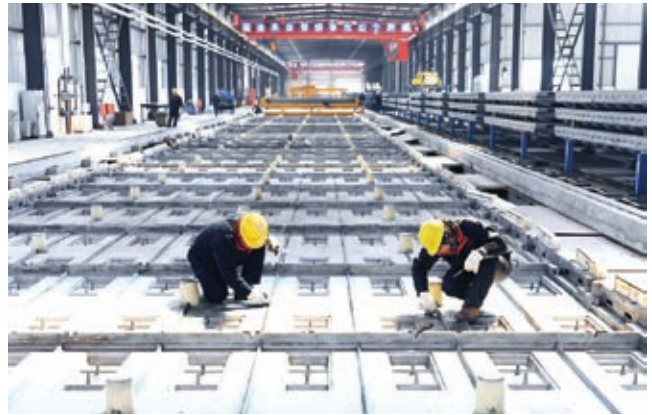
中铁四局创新无砟轨道施工技术
