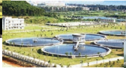
承建的深圳固戍污水处理厂
