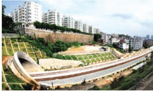
龙厦铁路仙龙隧道安全穿越居民区
