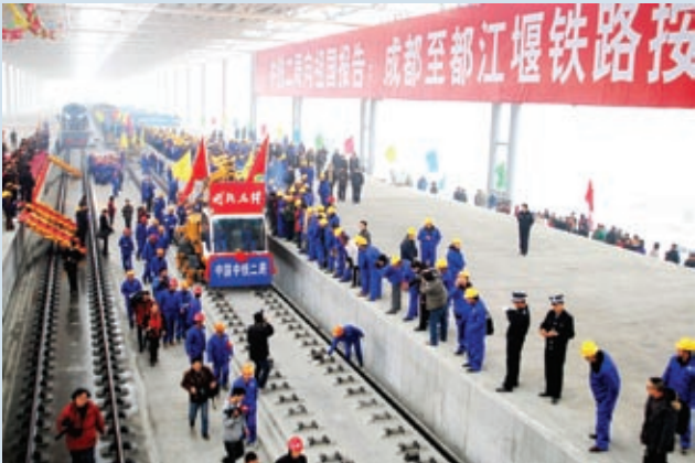
成都至都江堰铁路铺轨工程按期铺通
