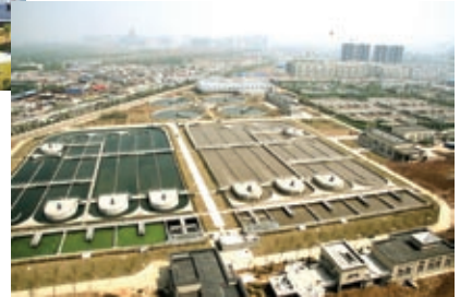
承建的合肥望棠污水处理厂
