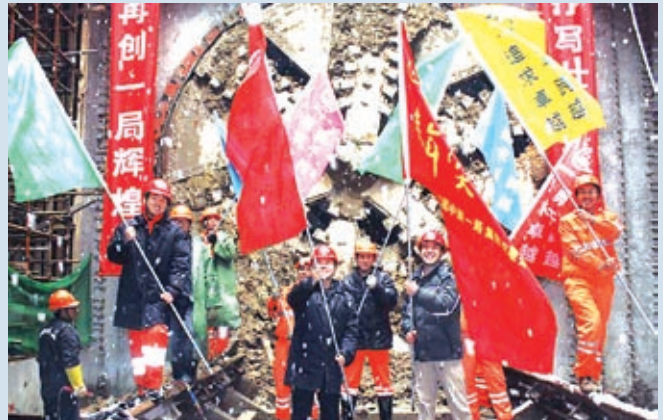
北京地铁八号线顺利贯通
